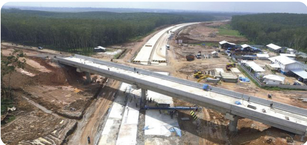
Gambar 1.2 Pembangunan jalan tol.
